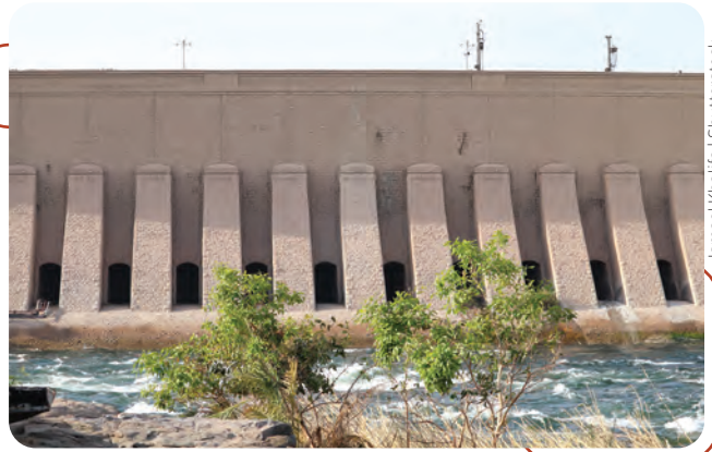
Barragem de Assuã, Rio Nilo.
